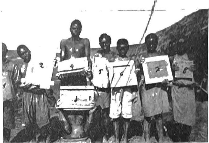
GITWE. — Fabrication de briques et de tuiles (de gauche à droite) : 1) moule à tuiles, 2) moule rempli, 3) forme vide, 4) forme pleine, 5) tuille sèche, 6) cadre pour briques, 7) le même cadre plein, 8) brique sèche.
