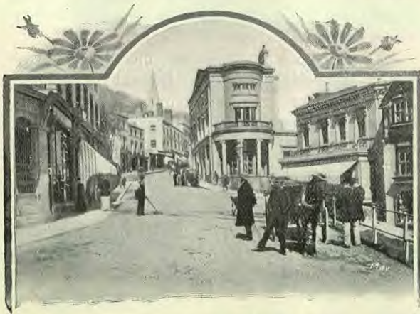
BELLE VUE TERRACE (MALVERN).
