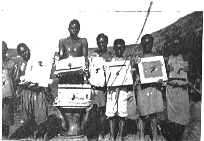
GITWE. — Fabrication de briques et de tuiles (de gauche à droite) : 1) moule à tuiles, 2) moule rempli, 3) forme vide, 4) forme pleine, 5) tuille sèche, 6) cadre pour briques, 7) le même cadre plein, 8) brique sèche.
